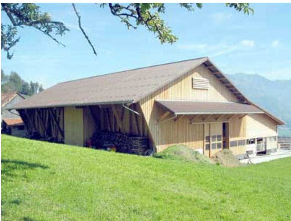
Dřevěné konstrukce stájových objektů v Sarnenu(Švýcarsko)
