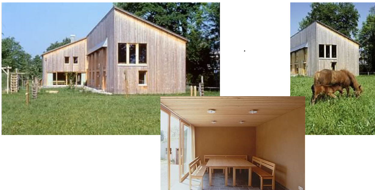
Projekt a realizace statku Greußinghof (chov koní), Lauterach, Rakousko autor: architekt Hermann Kaufmann
