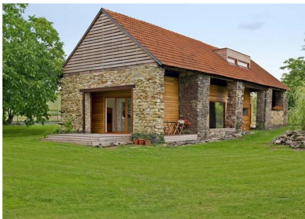
Obr. 15. Rekonstrukce kamenné usedlosti.
