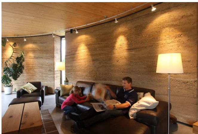
Obr. 18. Rodinný dům v severním Německu z dusané hlíny.
