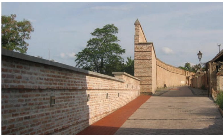
Obr.19. Prezentácia chýbajúcich častí opevnenia metódou architektonizovanej ruiny, ktorá posunula prezentáciu ruiny architektúry do polohy umeleckého torza (Zdroj: foto autorka)
