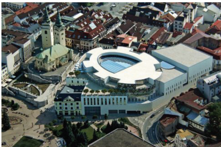
Obr.11. Predimenzovaná štruktúra polyfunkčného centra, ktorá vznikla na mieste stredovekého mestského hradu (Internetový zdroj-10)
