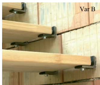
Obr. 12: Upravené připevnění stupnic do nosné zdi – Var A, Var B s výpočtovým modelem.
