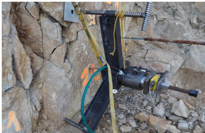
Obr. 10 Osazený GFRP horninový svorník při provádění trhací (pull-out) zkoušky; [46]
