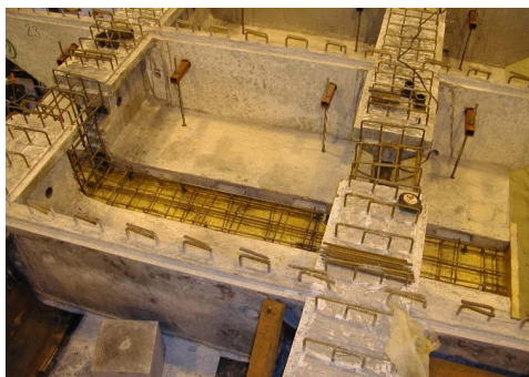
Obr. 7.12 Dobetonávka mezi segmenty vahadla a pole
