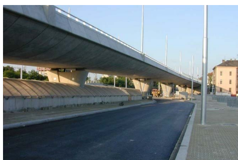
Obr. 7.4 Most přes ulici Mikulášskou v Plzni
