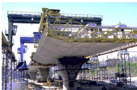
Obr. 7.3 Montáž mostu v Plzni v symetrickém vahadle
