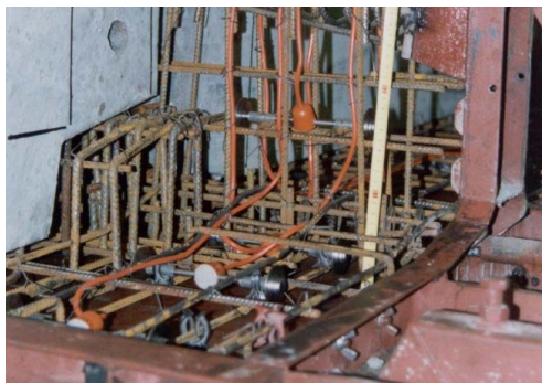
Obr. 6.1 Strunové tenzometry v armokoši před betonáží segmentu
