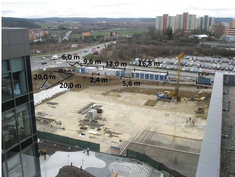
Obrázek 7 Reálný staveništní provoz, měření terénu a umístění objektů zařízení staveniště pro vložení do akustického modelu [©kantova.r@fce.vutbr.cz]
