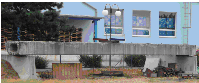
Obr. 27 Železobetonový nosník s osazeným zatěžovacím rámem
