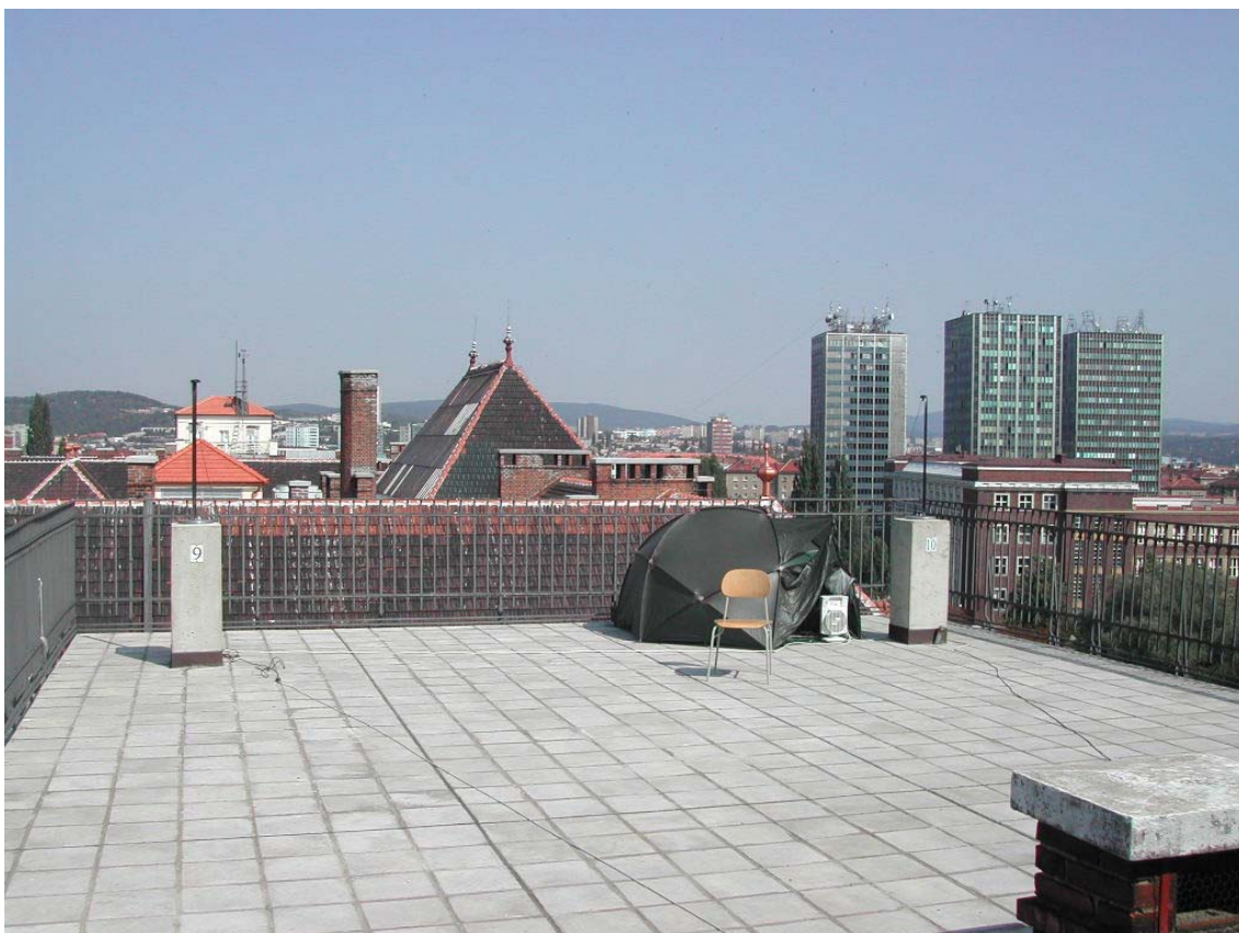
Obr.6.3. Celkový pohled na pilíře P9 a P10 s konzolami pro externí antény GARMIN
