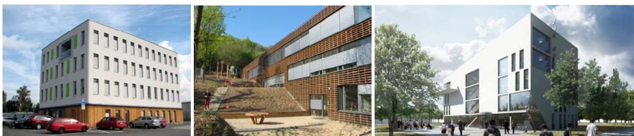
Obr. 6 (zleva doprava) Budova firmy Intoza v Ostravě (foto: autor), Otevřená zahrada v Brně (foto:autor), ZUŠ Holice (zdroj: Dobrý dům, s.r.o.)
