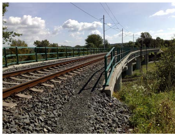
Obr. 7 Most Gagarin po rekonstrukci
