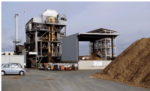
Obr. 2 Kogenerační spalovna dřevní štěpky v městě Güssing v rakouské spolkové zemi Burgenland Foto: Josef Chybík
