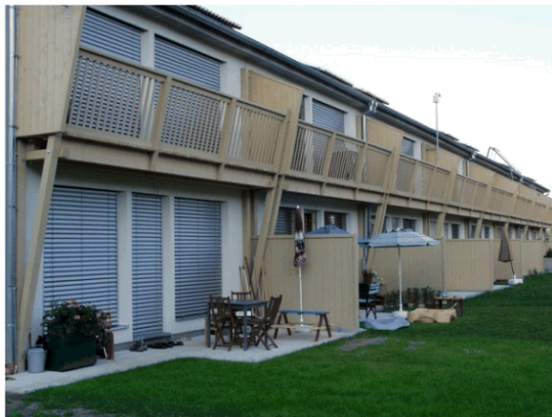
Obr. 2.3 Pohled na jihozápadně orientovanou fasádu řadových PD Foto: Josef Chybík
