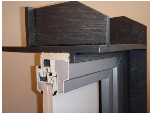
Obr. 25 Model prototypu I osazovacího rámu – a) detail u parapetu b) detail v nadpraží
