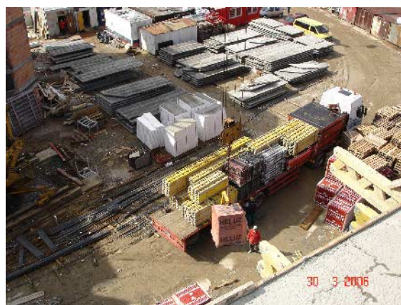
Obr.21 Zásobování stavby zdicím a bednicím materiálem
