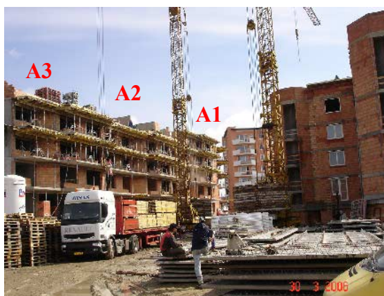
Obr.20 Průběh výstavby 5.NP
