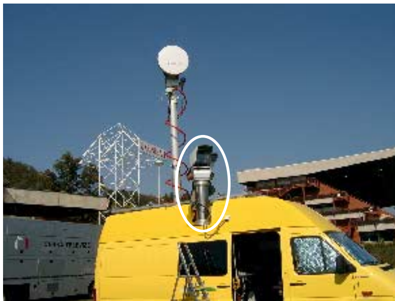
Obr. 3.5 Ukázka instalace hlavice AOS na přenosovém vozu
