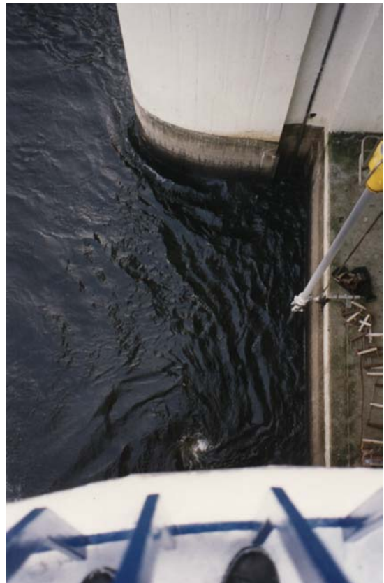
Obr. 12 Vznik vtokových hladinových vírů v předpolí dolního reverzního vtoku PVE Štěchovice – provozní zkoušky
