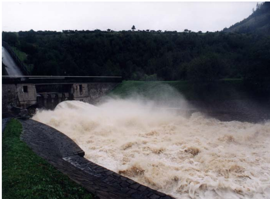
Obr. 13 Měření průtoku vzduchu přisávaného do komor rozstříkovacích uzávěrů VD Slezská Harta, Vír, Šance za účelem stanovení součinitele provzdušnění reálného proudu \beta = Q_a/Q
