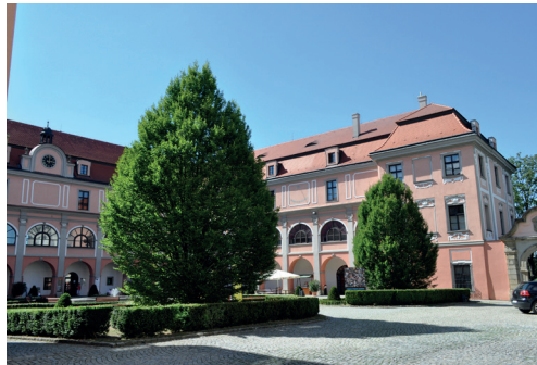
Obr. 10. Nádvorie zámku Žerotínov vo Valašskom Meziříčí (zdroj: archív autorky)
