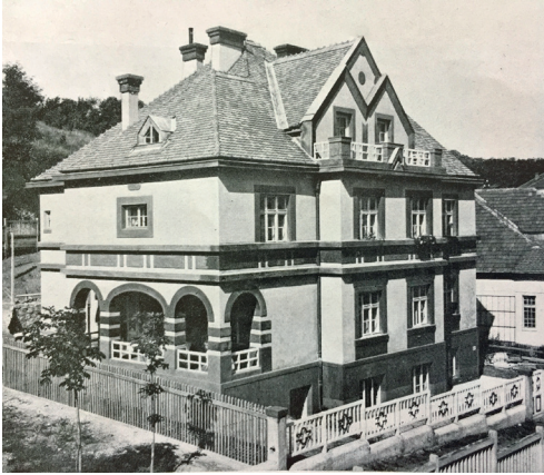
Obr. 1. Dvojvila architektov Aloisa Balána a Jiřího Grossmanna (zdroj: Hořejš, A.: Inž. Arch. Alois Balán a Inž. Arch. Jiří Grossmann: 10 rokov architektonickej práce. Slovenská grafia, Bratislava, 1932)
