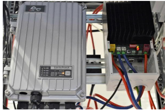
Obr. 20 Regulař nabíjení Variotrack a Mornistar (vpravo)
