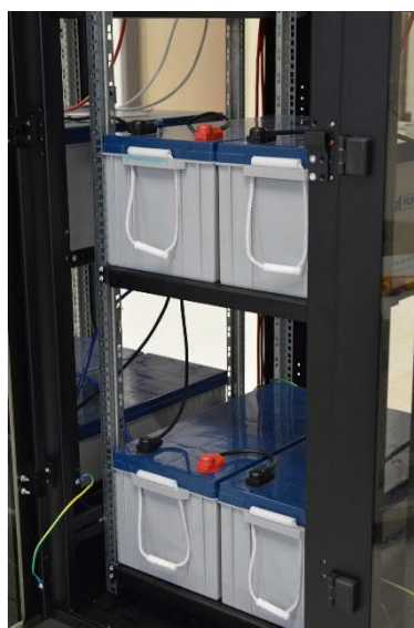
Obr. 16 Olověné akumulátory
