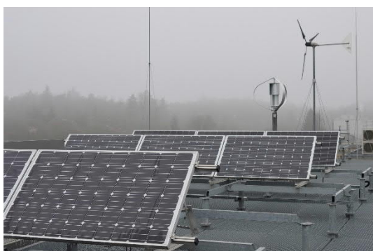
Obr. 17 Střešní část instalace
