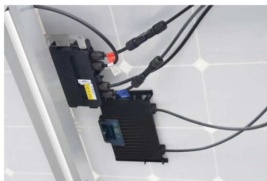
Obr. 18 Retrofit Tigo TSR-4(A-O)
