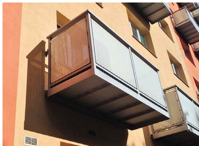
Obrázek 2 Detail zavěšeného balkonu
