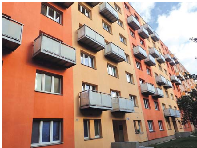
Obrázek 1 Obytný dům se zavěšenými balkony
