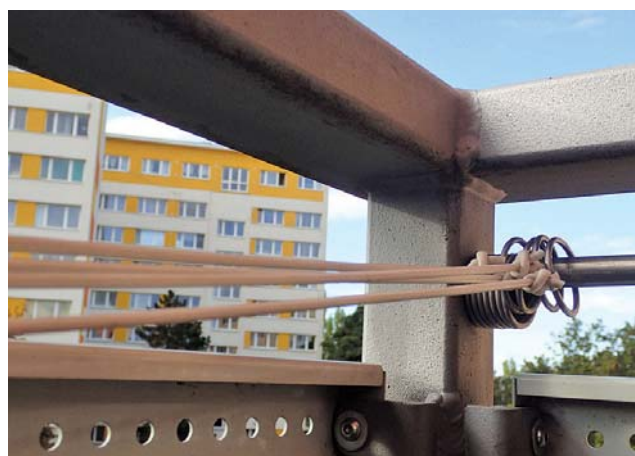
Obrázek 3 Detail připojení rohového sloupku k madlům balkonu
