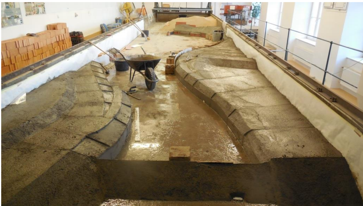
Obr. 52 Vyhotovení betonové skořepiny modelu
