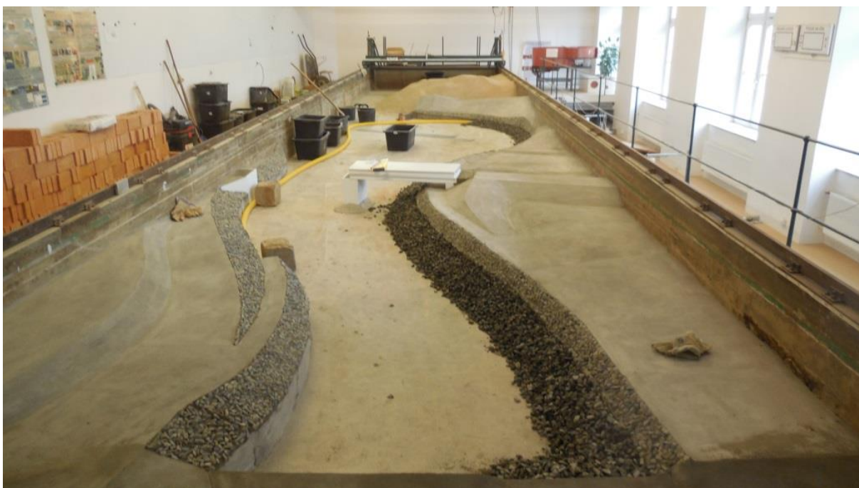
Obr. 53 Úprava pohledovým betonem, zhotovení opevnění svahů a umístění drenážního potrubí s obsypem
