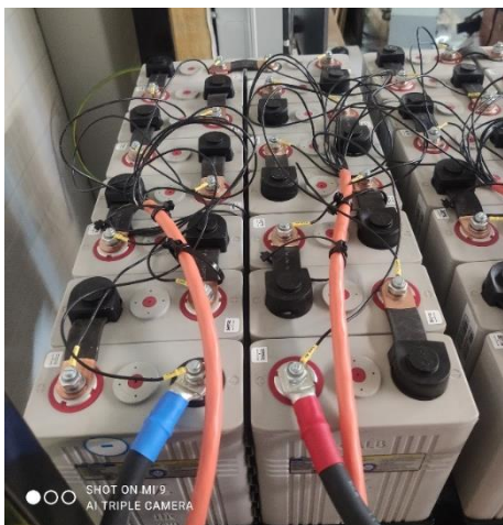
obr. 7 Základní modul (51,2 V DC ) pro HVB
