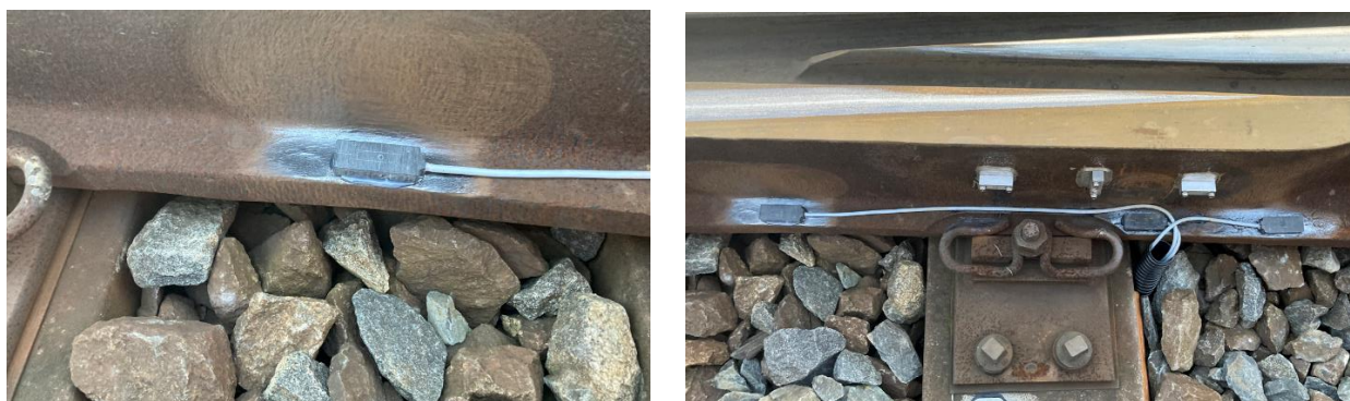
Obr. 2 Detail instalace jednoho funkčního vzorku snímací vrstvy a příklad instalace sady 3 sensorických vrstev jednotlivých funkčních vzorků.
