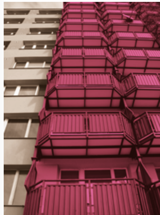
OCELOVÉ BALKONY S PLECHOVÝM ZÁBRADLÍM [267] Ulice Arbesova.
