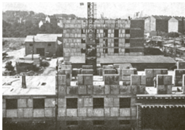
KVÁDROVÉ BYTOVÉ DOMY [13] Předem vyrobené a očíslované blokopanely (kvádry) byly na stavbě osazovány dle kladečského výkresu na přesně danou pozici.
