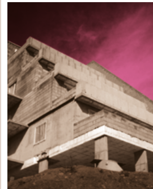
BYTOVÉ DOMY NA ULICI TOMEČKOVA [309] Hrubá stavba domu s terasami.
