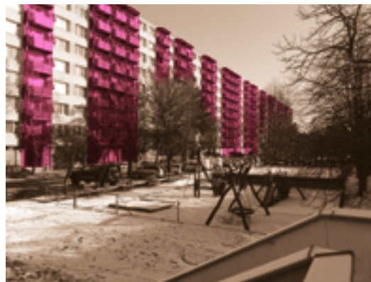
OCELOVÉ BALKONY PO REVITALIZACI DESKOVÉHO DOMU [264] Ulice Arbesova v roce 2016.
