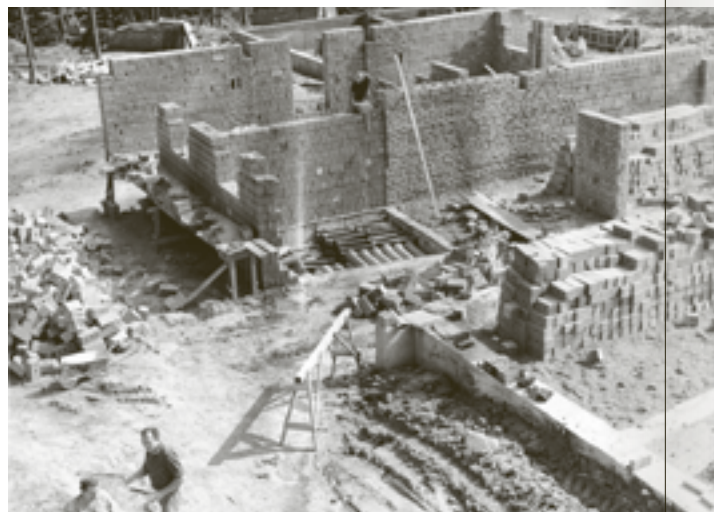
VÝSTAVBA ŘADOVÝCH DOMŮ [211] Ulice Kupkova.
