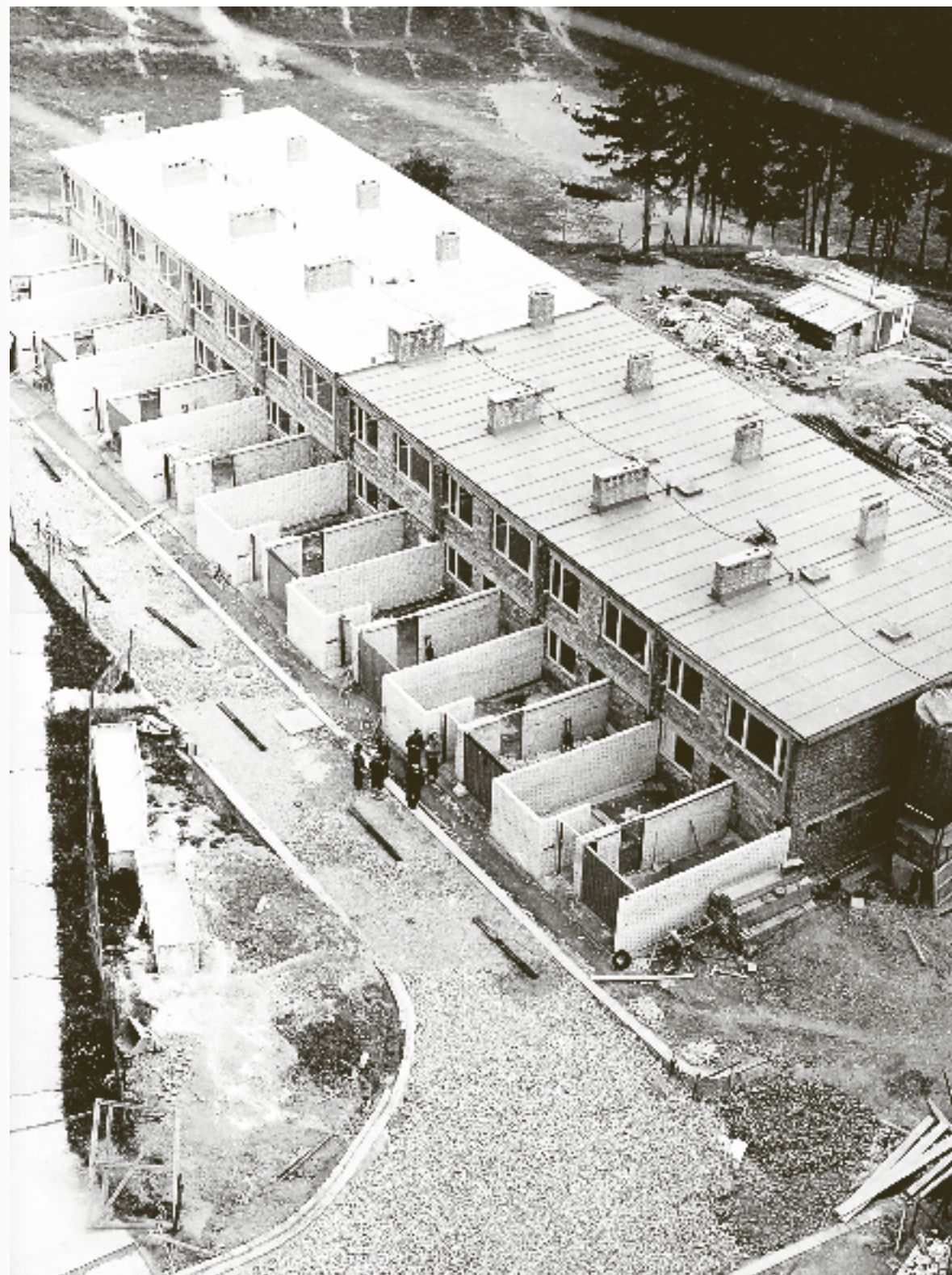
VÝSTAVBA ŘADOVÝCH DOMŮ NA ULICI LOOSOVA [229]
