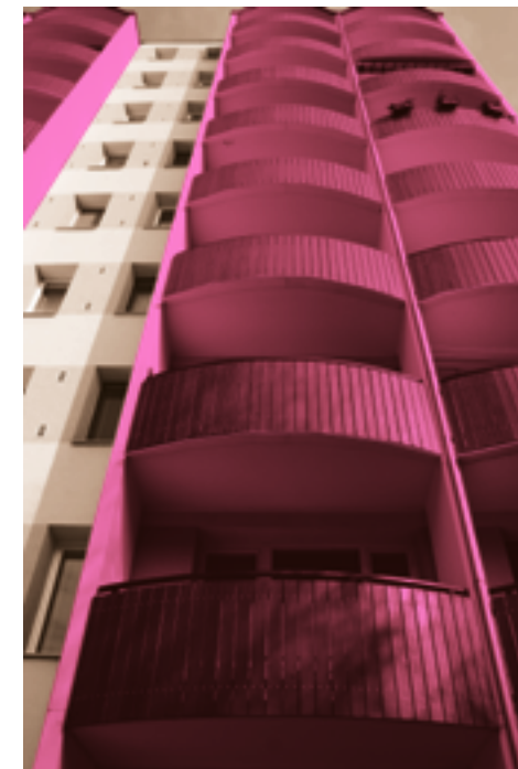
BETONOVÉ LOGGIE S DŘEVĚNÝM SEGMENTOVÝM ZÁBRADLÍM [268] Ulice Nezvalova.
