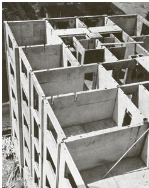
BYTOVÝ DŮM G-40 [17] Před zastropením. Na obrázku je dobře patrna krycí funkce mezipanelového pilastru při styku jednotlivých stěnových panelů.
