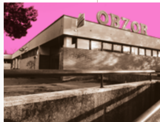
OKRSKOVÉ CENTRUM OBZOR [243] Pohled na jižní křídlo centra z přístupové rampy v roce 2015.
