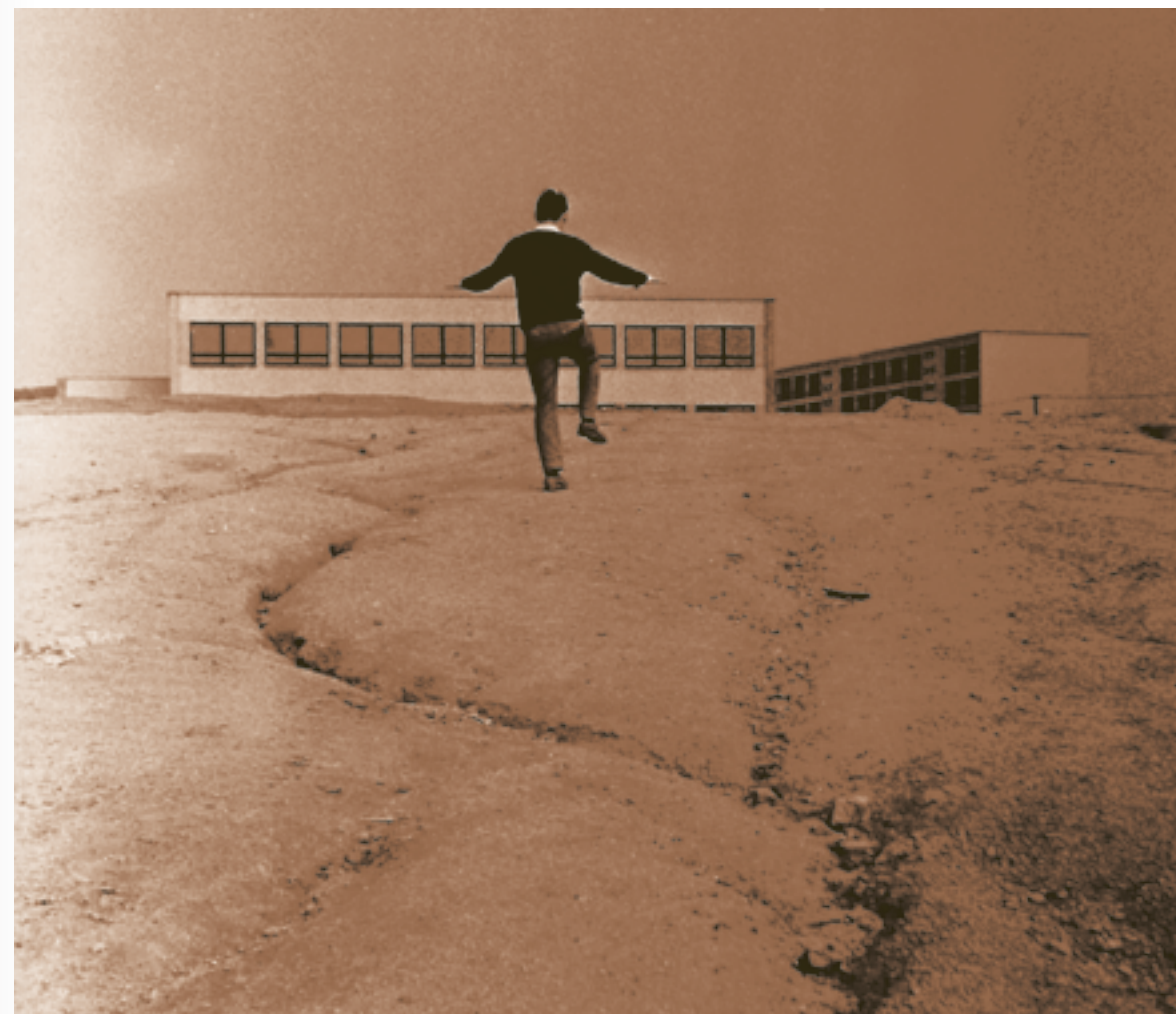
HOSPODÁŘSKÝ BLOK NA ULICI NEJEDLÉHO [359]
