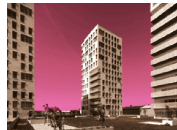
VÝŠKOVÉ DOMY ORION [326] Pohled na trojici věží ze společné platformy s parkovou úpravou.
