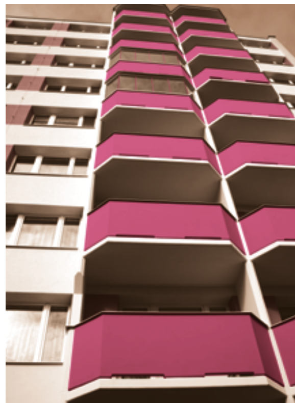
[272] Ulice Brožíkova. Po povrchové úpravě a zateplení objektu.
