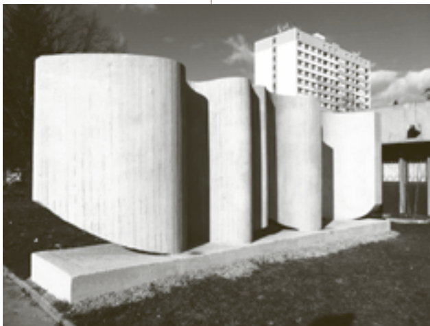
DEKORATIVNÍ STĚNA [186] Jánuš Kubiček, monolitický beton 49°13'24.892"N, 16°37'31.856"E
