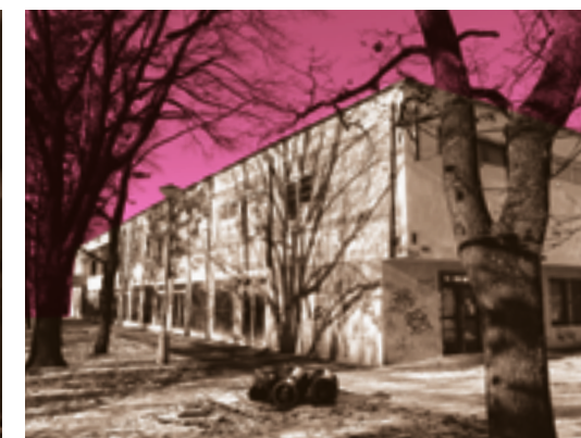
OKRSKOVÉ CENTRUM DUKÁT [247] Fasáda exteriéru v pohledu z jižní strany v roce 2015.
