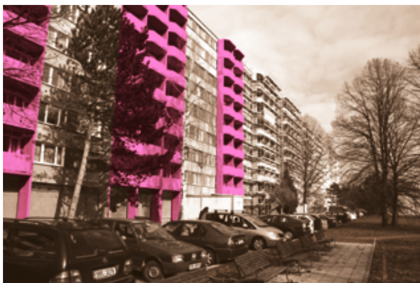
REVITALIZACE DESKOVÉHO DOMU [273] Přístavba loggií a zateplení objektu na ulici Brožíkova.
