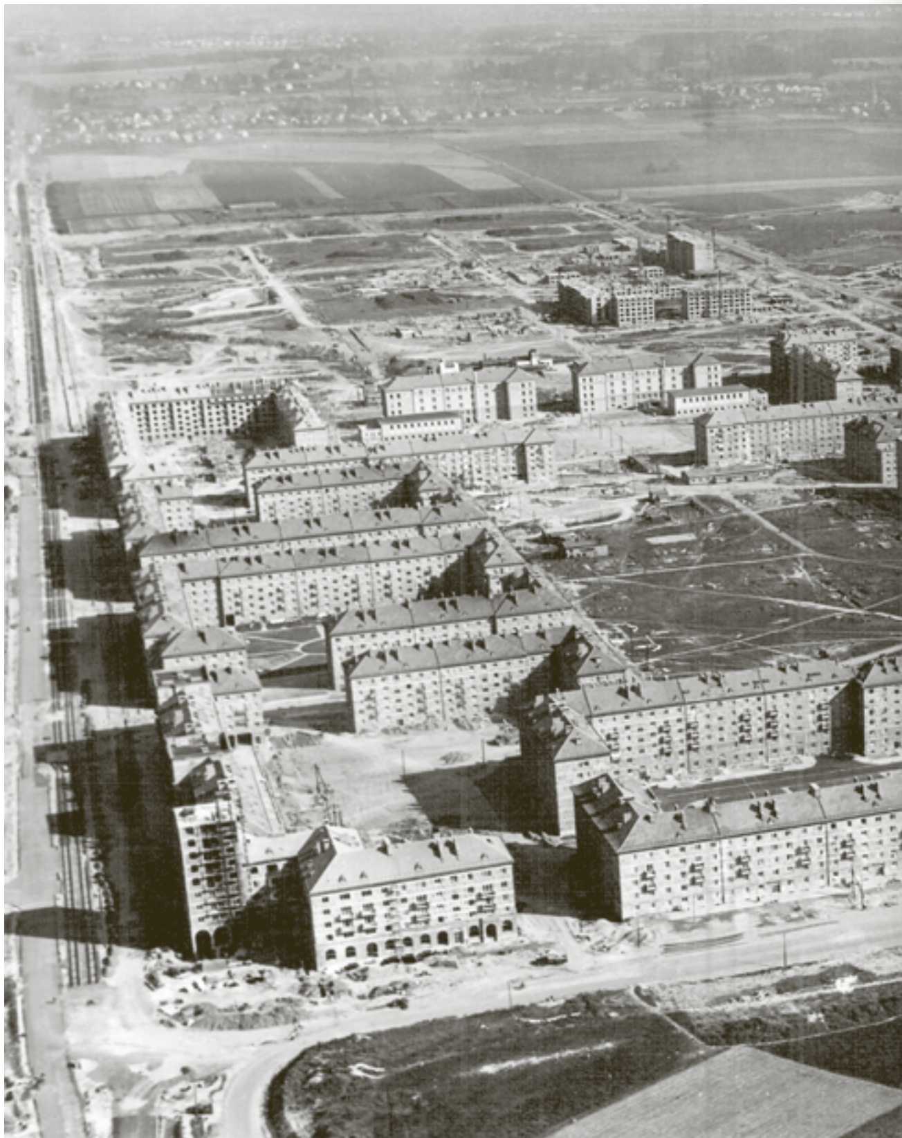
OSTRAVA-PORUBA [12] Letecký pohled na staveniště I. obvodu budoucí Nové Ostravy.
