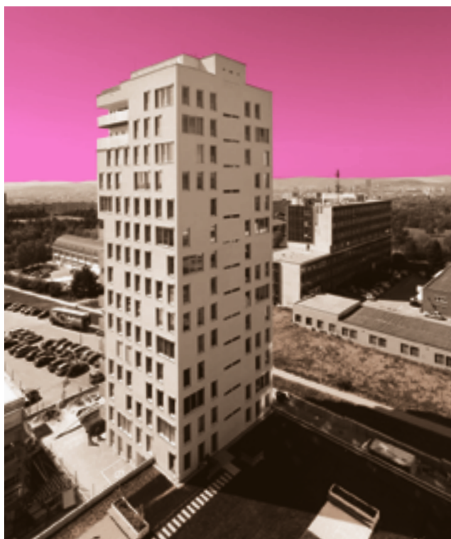
VÝŠKOVÉ DOMY ORION [325] Pohled na jižní věž. V pozadí budovy Českého metrologického institutu a administrativní budova bývalého VÚGI.
