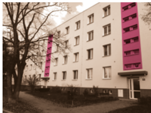
NÍZKOPODLAŽNÍ DOMY NA ULICI NEJEDLÉHO [292] Před zateplením a po zateplení fasády. Na obrázku je patrné výrazné působení nově vyměněných bílých oken oproti původním černým na schodištích. Barevné členění modrými čtverci ztrácí na dominanci a tuto roli přebírají nová okna.
