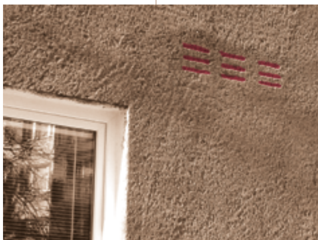
[294] Větrací mřížky vytvořené štěrbinami v omítce.
