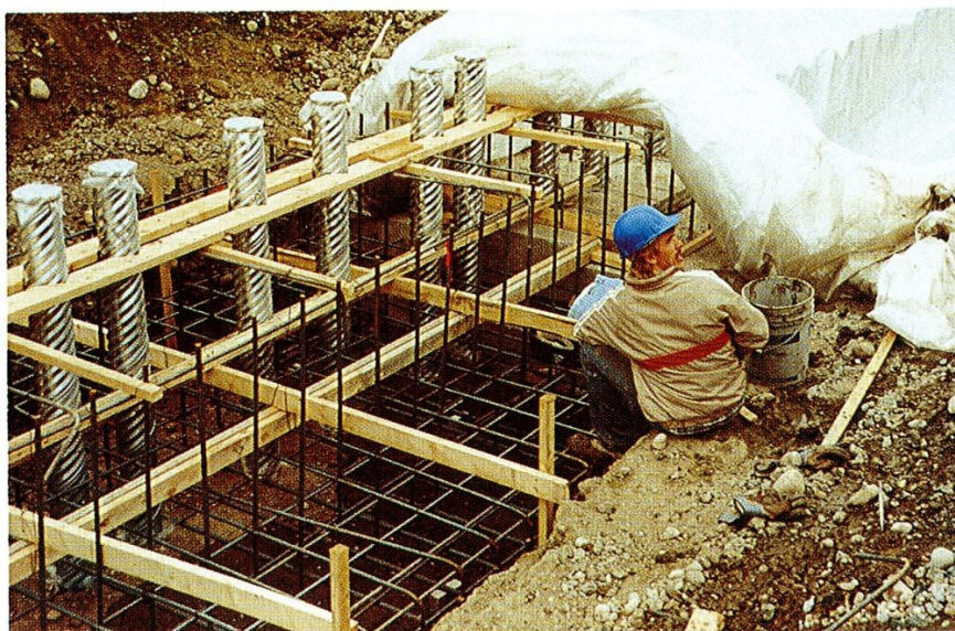
Obr. B.8 Výstavba základových pasů přesypané klenby v Albertě (Montgomery, et al., 1993).
