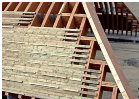
Obr. 1.20 Přesypaný dřevěný ekodukt, Poprad - výstavba (Matějů, 2008).
