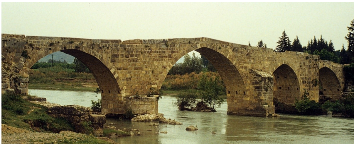
Obr. 1.2 Římský most přes řeku Eurymedon v Turecku postavený ve 4. století (Wikipedie, 2011).
