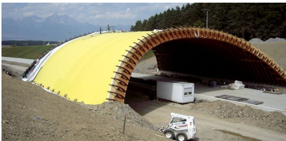
Obr. 1.21 Přesypaný dřevěný ekodukt, Poprad - výstavba (Matějů, 2008).
