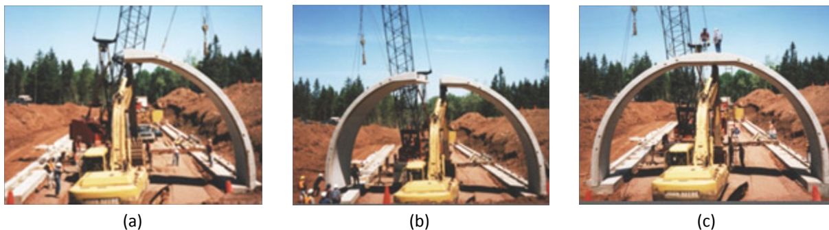
Obr. 1.4 Postupná výstavba prefabrikovaných segmentů systému BEBO (BEBO, 2013).
