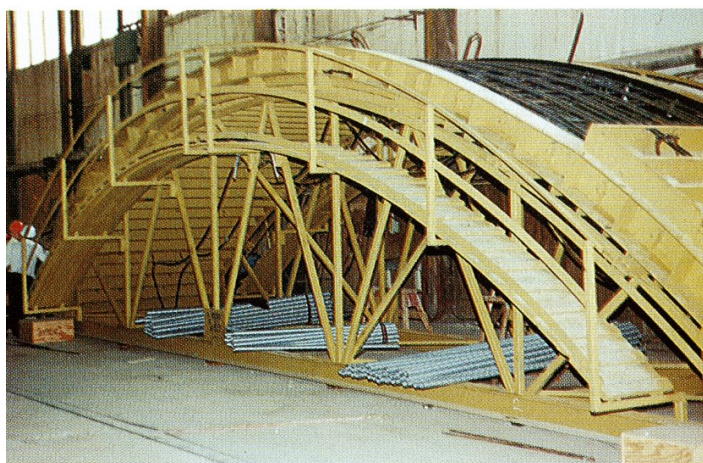
Obr. B.3 Bednění segmentu klenby (Montgomery, et al., 1993)
