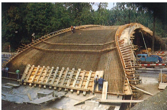
Obr. 1.11 Výstavba přesýpaného obloukového mostu – Stuttgart (Holgate, 1997).
