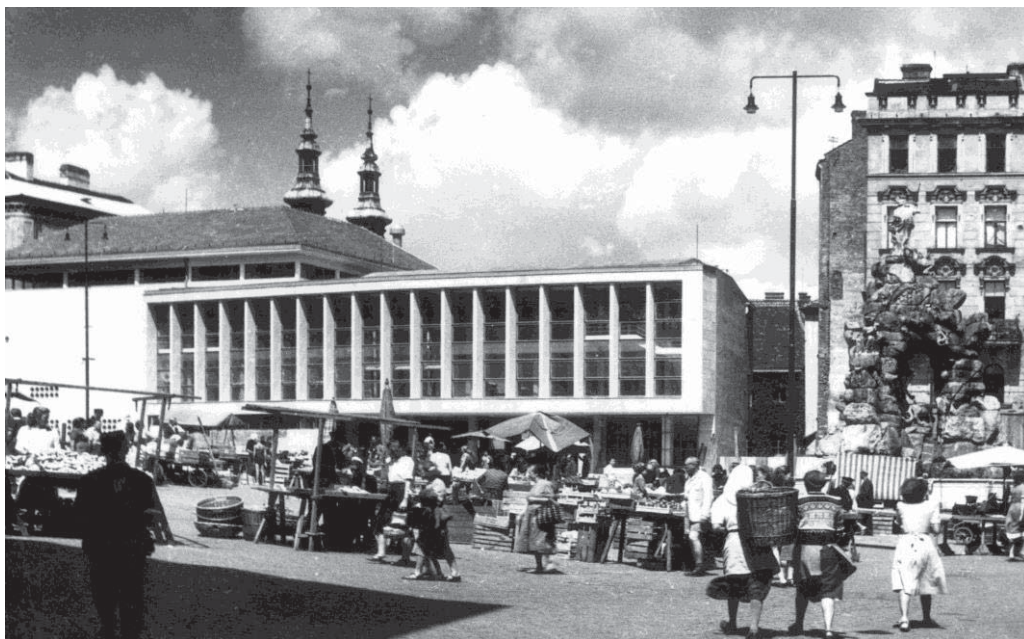
Městská tržnice, Zelný trh 250/14, Emanuel Hruška a Vilém Zavřel, 1947
