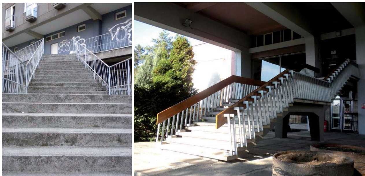
Koleje „Leninova“, venkovní schodiště do dvora, 2012. Schodiště do budovy NCONZO (viz výše)
