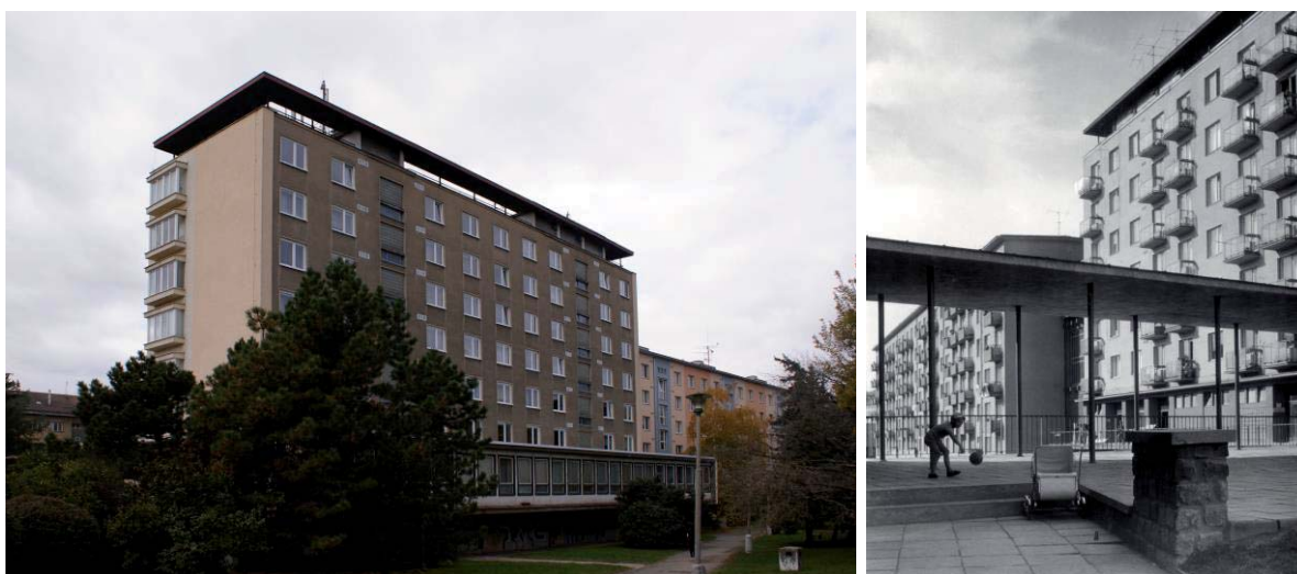
Bytový dům se zdravotním střediskem, Bakalovo nábřeží 1/1, 1957–1961
