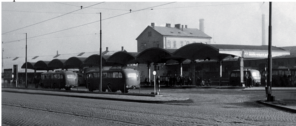
Zastřešení autobusového nástupiště, Benešova ulice, Bohuslav Fuchs, Konrád Hruban 1945–1946
