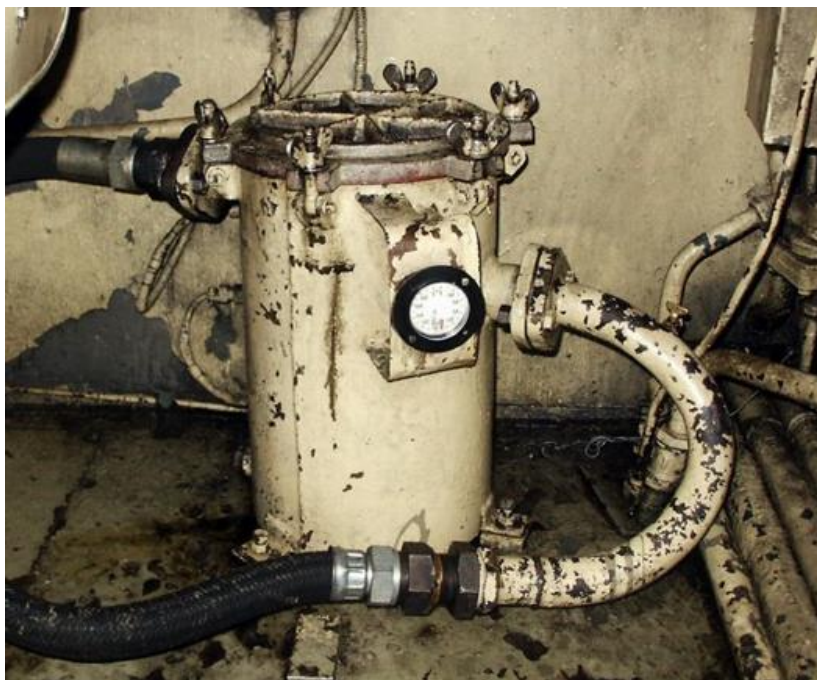
Obr. 24 Kontrola difference tlaku čističe oleje [12]
