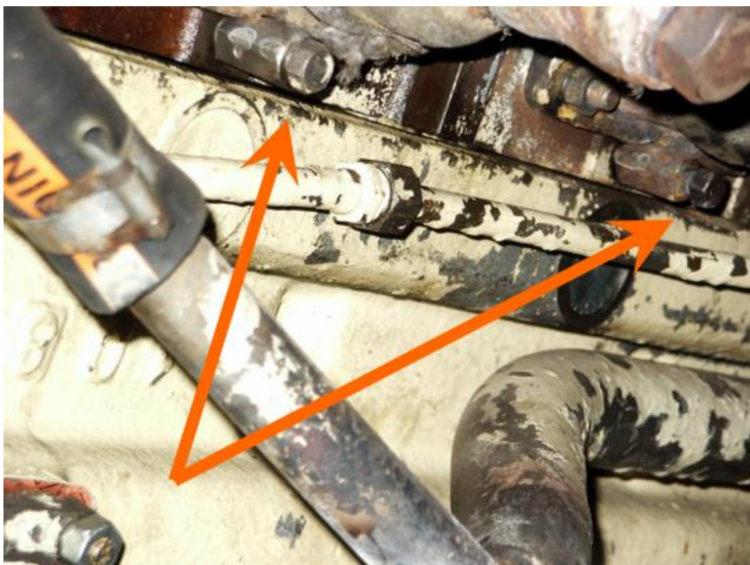
Obr. 22 Šrouby pod přírubou výfukového potrubí tzv. "syčáky" (šipkami označené) [12]
