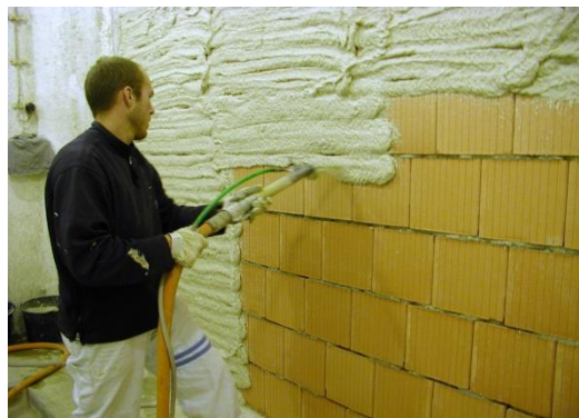
Obr. 1: Strojní nanášení omítky [24]
