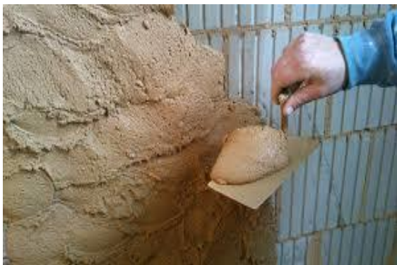
Obr. 1: Ruční nanášení omítky [24]
