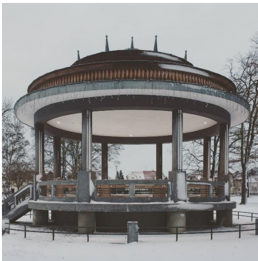
Obr. 43. Hudební pavilón v dnešní podobě [Zdroj: [80] ]
