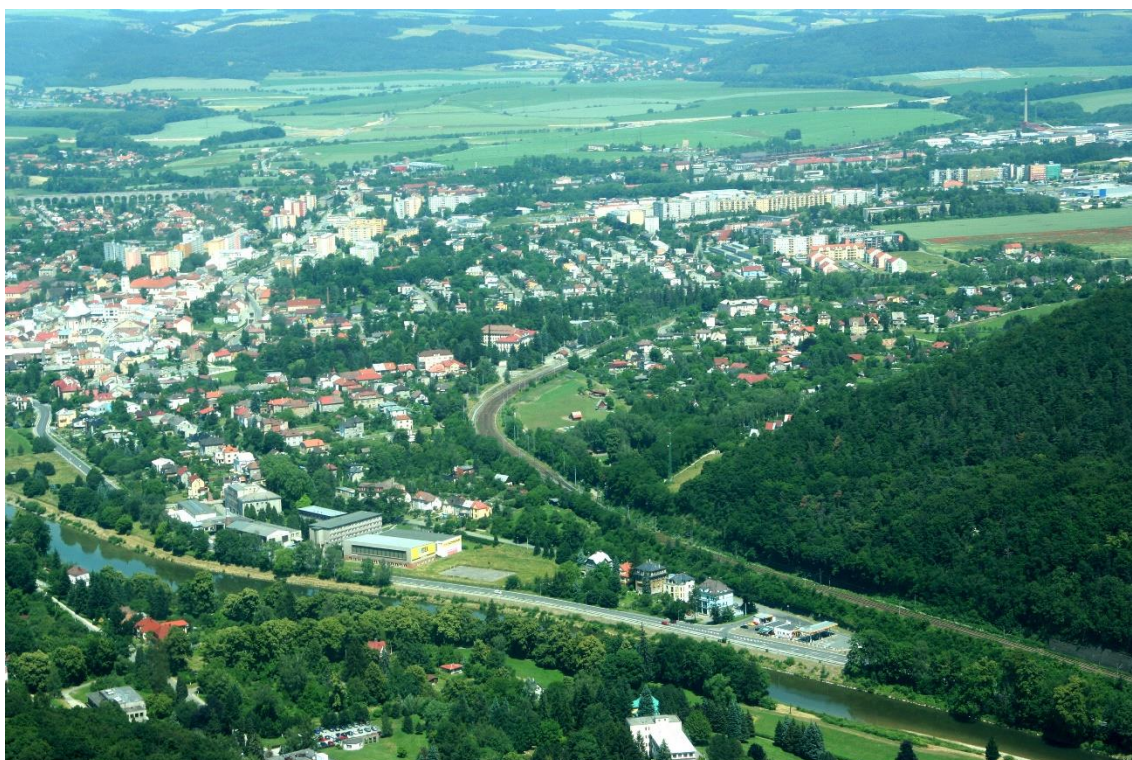
Obr. 3 Pohled z východu (Foto: Ing. Libor Gajdoš, 2008)
