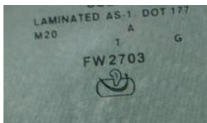
Obr. 7- Označení akustického skla (11)
