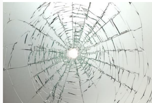
Obr. 3- Rozbité vrstvené sklo (17)
