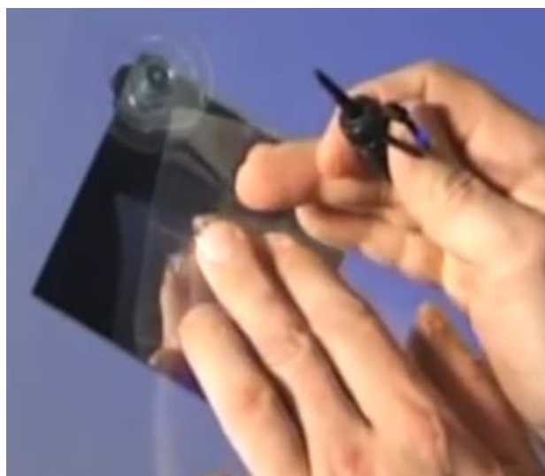
Obr. 62- Výstřížek 14- úprava poškozeného místa dokončovací pryskyřicí (31)
