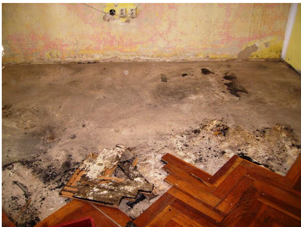
Obr. 42, 43: Napadnutá nášlapná vrstva podlahy rhyzomorfami
