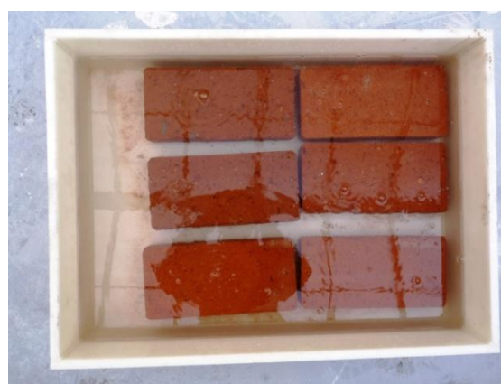
Obr. 8 a 9: Namočení cihel a vyzdění pilíře 600x300x240 mm
