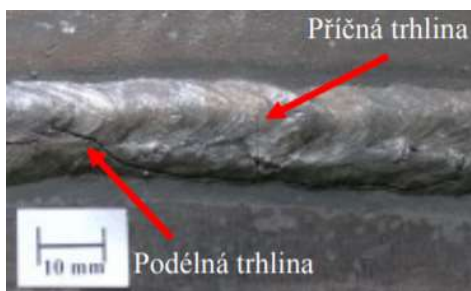
Obr. 4.0 Trhliny ve svaru [32]
