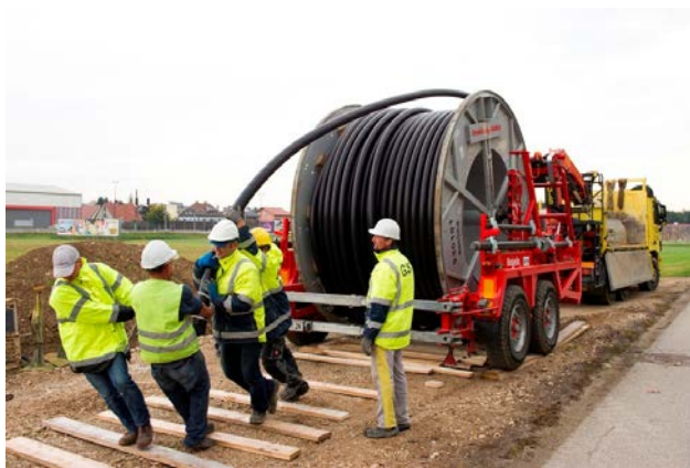
Obr. 7.2 Odvíjení kabelu 110 kV z bubnu [8]
