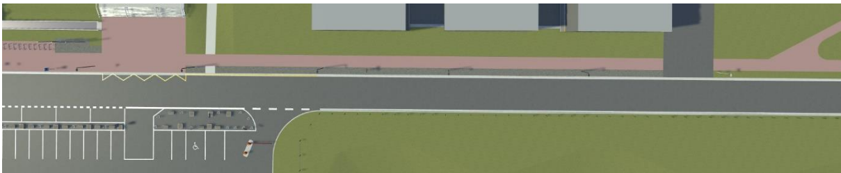
Obr. 23 Chodník vedoucí podél budov FSI
